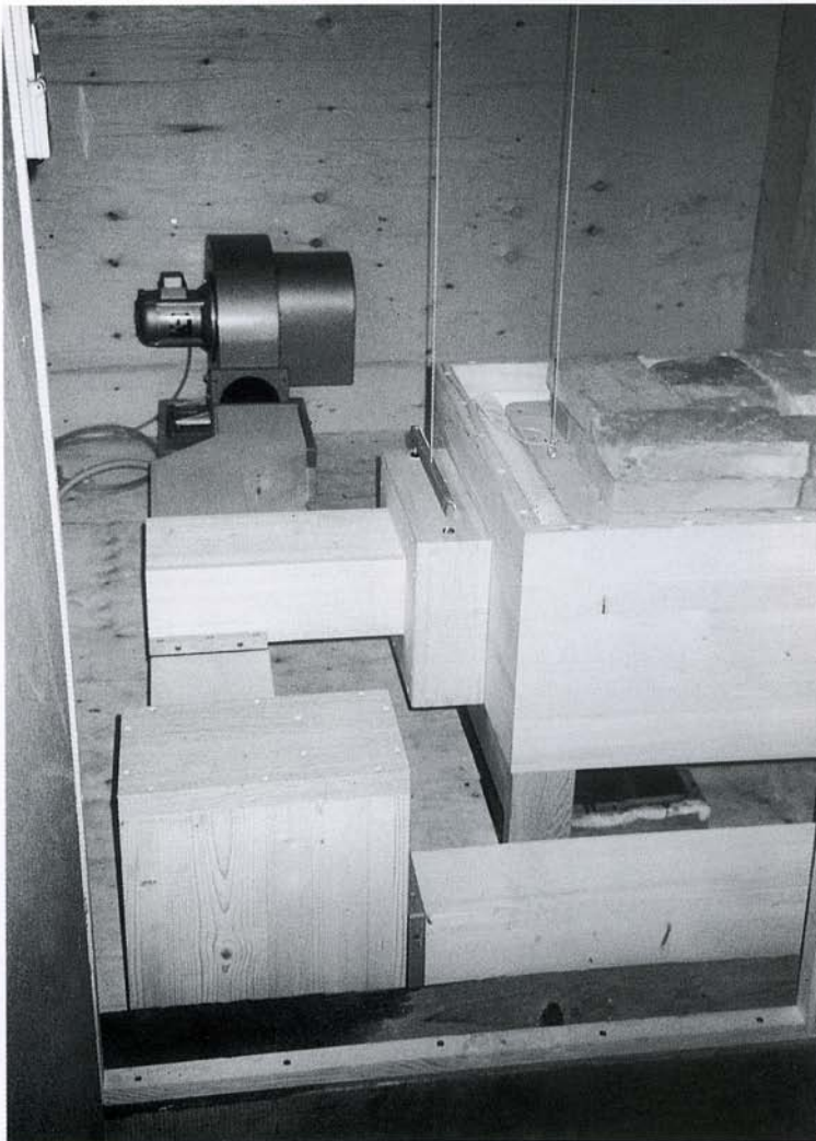
Gebälsehaus auf dem Dachboden.
